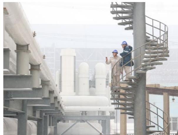
▶ 托克托發電公司雪中巡檢保供電
