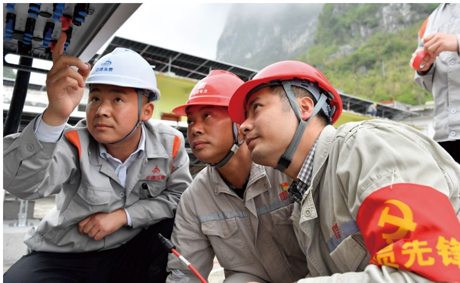
李云在查看屋顶光伏项目建设情况
