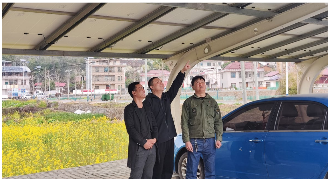
李维在光伏发电车棚检查
